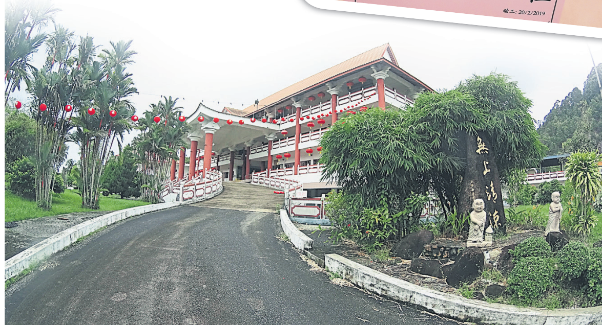
第二期建设工程
